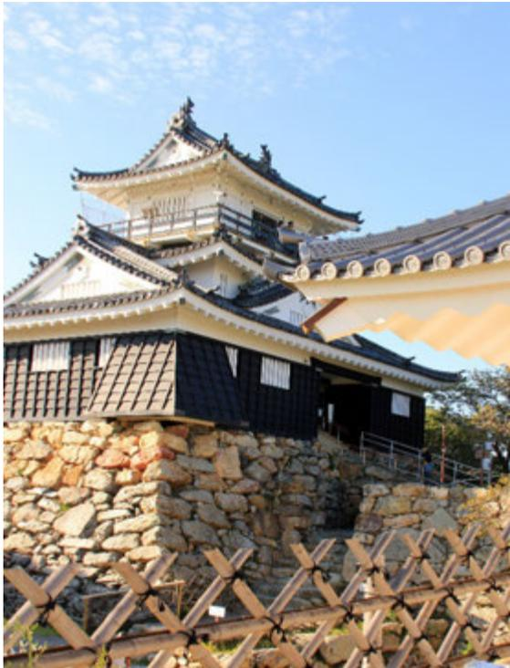
のづら野面積み 自然石を上下に組み堅固で崩れない
