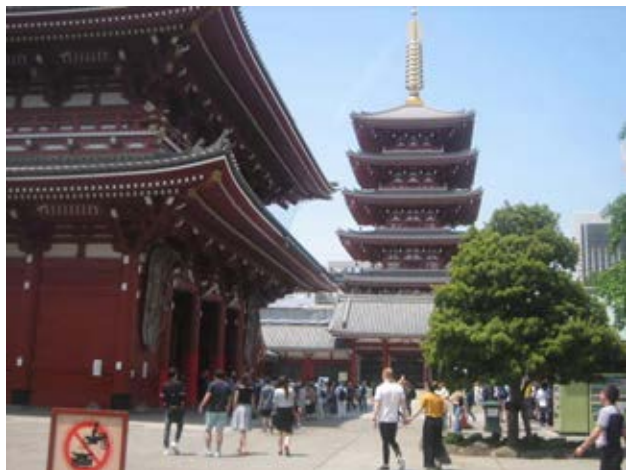
修復が完了した五重塔
