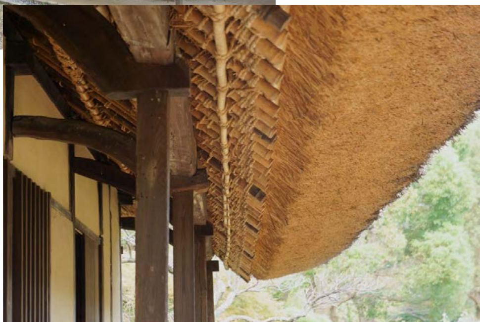
葺き替えを終えた屋根、下から見る萱の厚みはすごい
